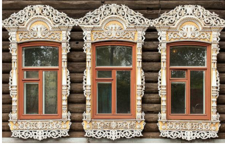
А) Деревянные наличники;
