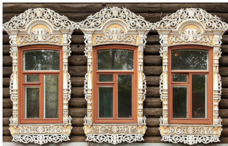
А) Деревянные наличники;
